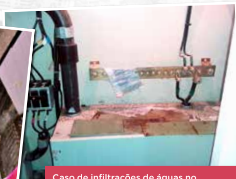
Caso de infiltrações de águas no quadro de medição da CEEE, considerada uma anomalia construtiva
