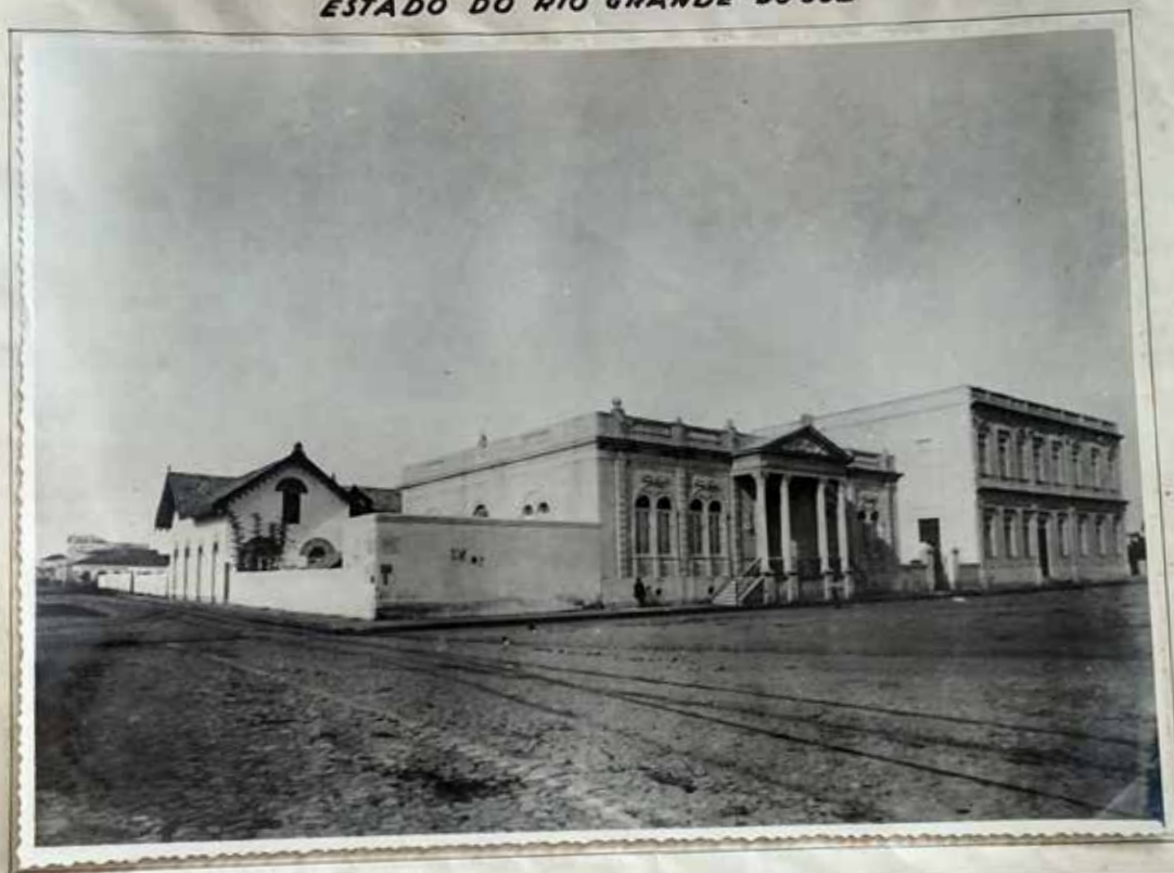
EDIFÍCIO DO LYCEU
